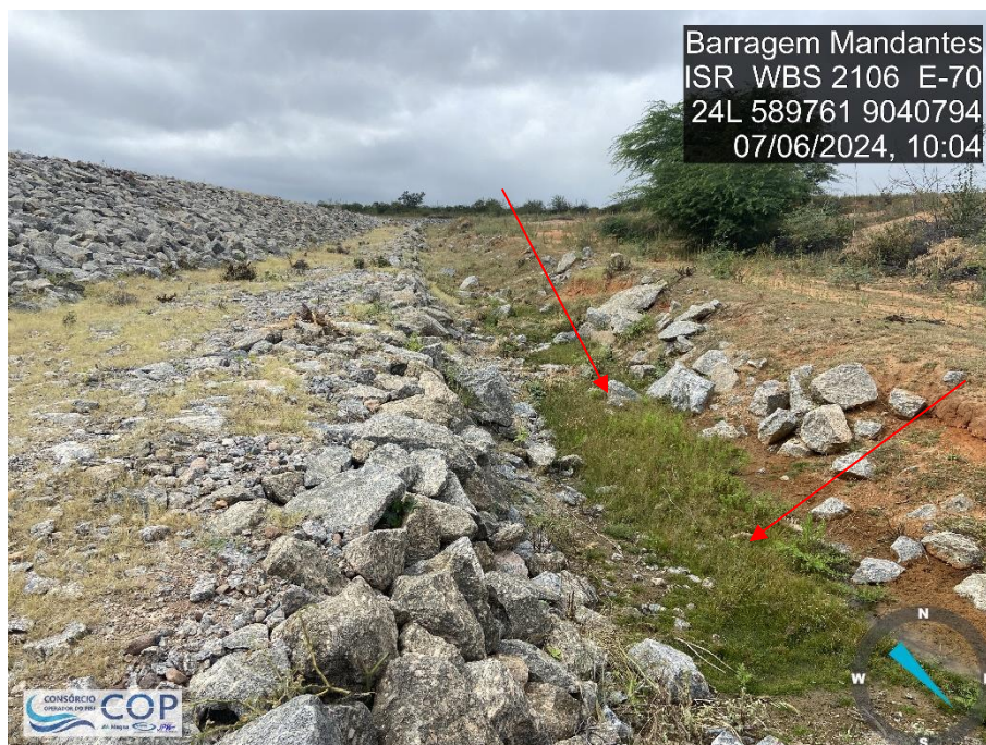
Foto 6.13: Surgência de água na região a jusante – Estaca 70+10.
