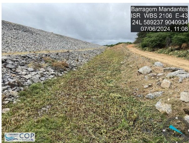
Foto 6.11: Surgências de água na região a jusante – Entre as estacas E-42+00 e E-50+00.
