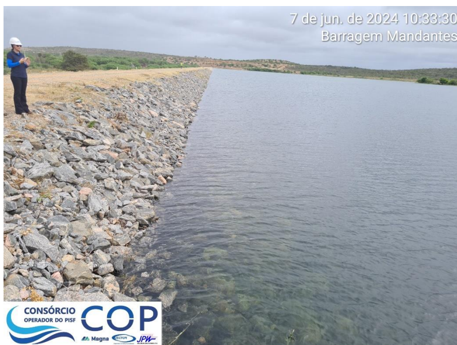
Foto 6.2: Vista do talude de montante.
