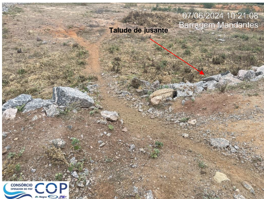
Foto 6.8: Deslocamento do material de proteção próximo ao muro lateral direito do vertedouro, ocasionado pela passagem de motocicletas e animais.
