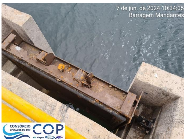
Foto 6.34: Sinais de oxidação na comporta ensecadeira e nas guias de descida da comporta/grade.
