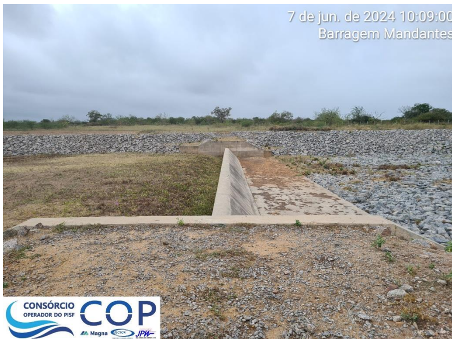
Foto 6.30: Falta de guarda-corpo de proteção nos muros laterais do vertedouro.
