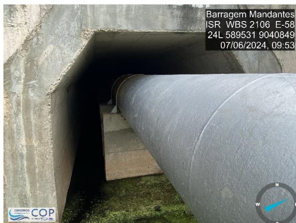
Foto 6.39: Surgência e acúmulo de água no interior da galeria.
