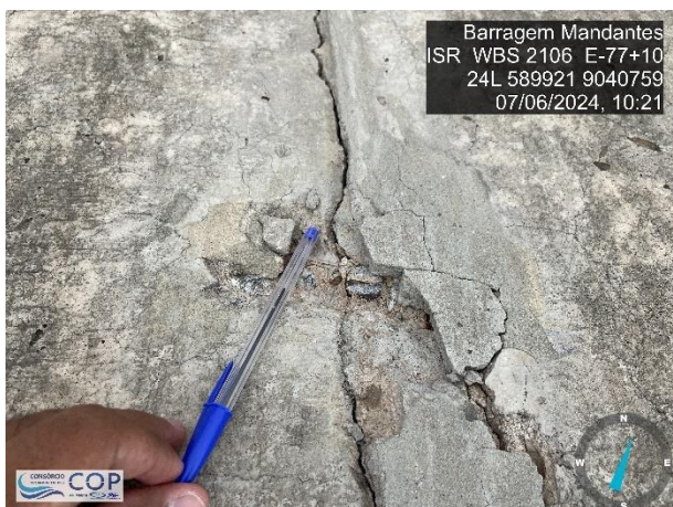
Foto 6.25: detalhe do mal acabamento do concreto da estrutura do vertedouro.
