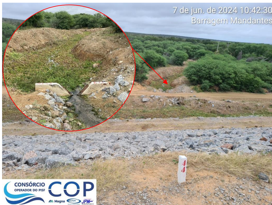
Foto 6.17: Medidor de vazão – MV-02 na estaca 43+00.
