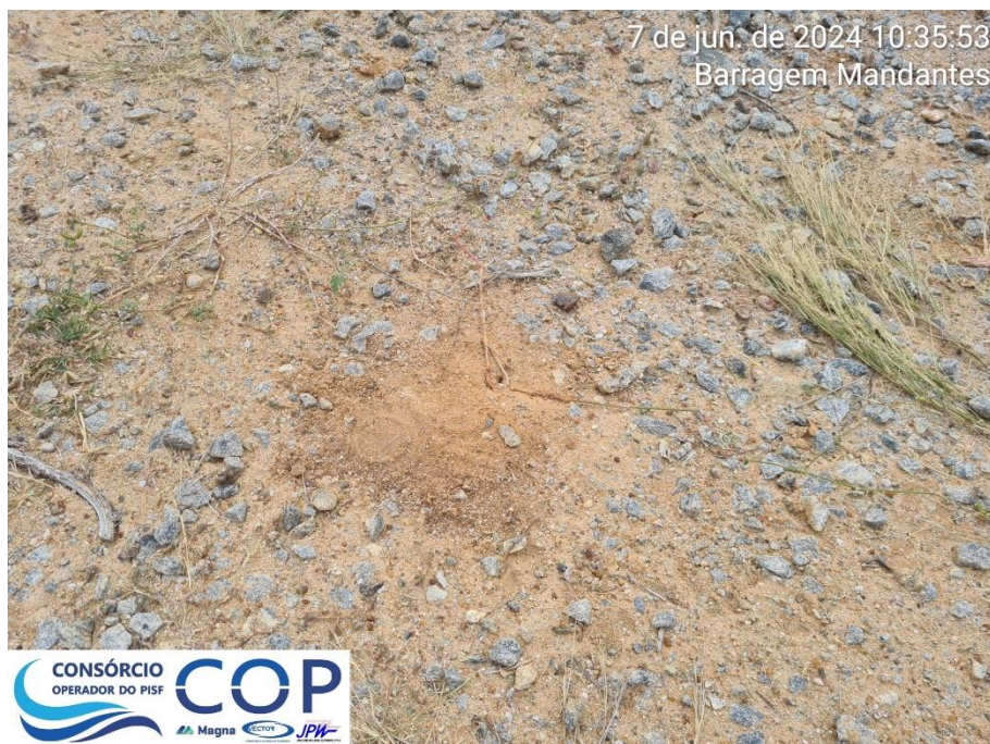
Foto 6.6: Presença de formigueiros em alguns pontos do coroamento.
