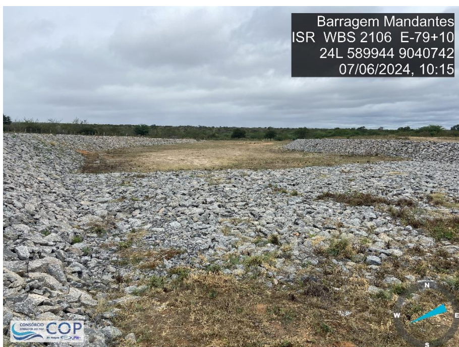
Foto 6.19: Vista do canal de restituição do vertedouro.
