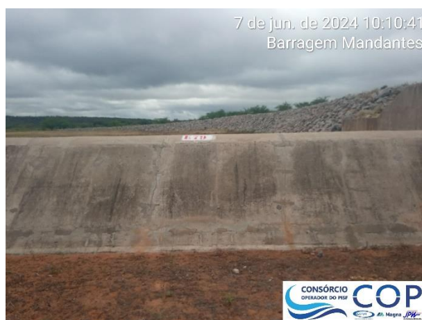
Foto 6.22: Fissuras superficiais de retração na estrutura do vertedouro.
