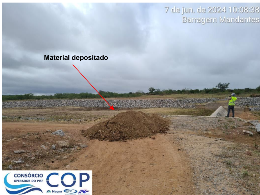
Foto 6.3: Material depositado no talude de montante, próximo ao muro do vertedouro.
