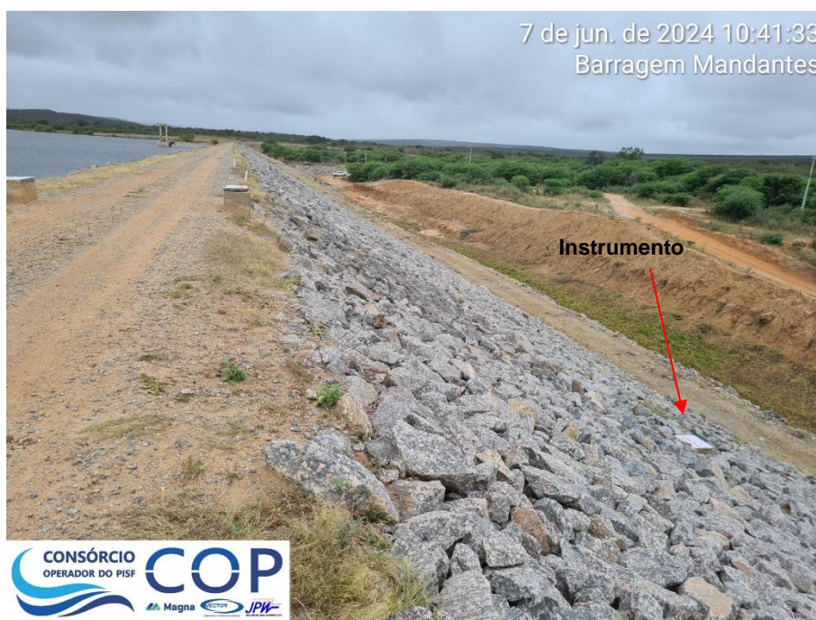
Foto 6.14: Falta de estrutura de acesso aos instrumentos na barragem.
