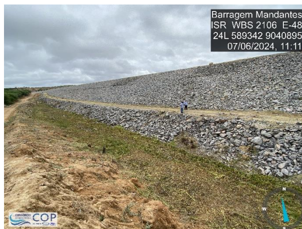
Foto 6.12: Surgências de água na região a jusante – Entre as estacas E-42+00 e E-50+00.
