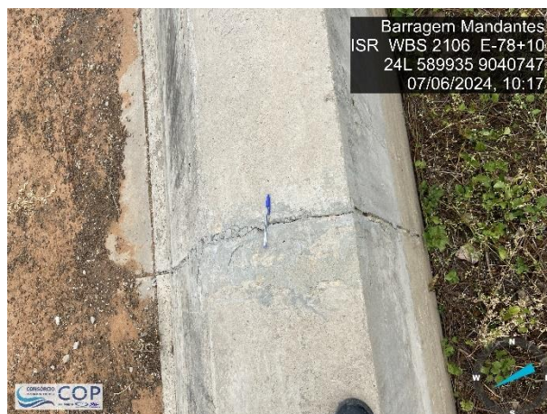
Foto 6.26: detalhe do mal acabamento do concreto da estrutura do vertedouro.
