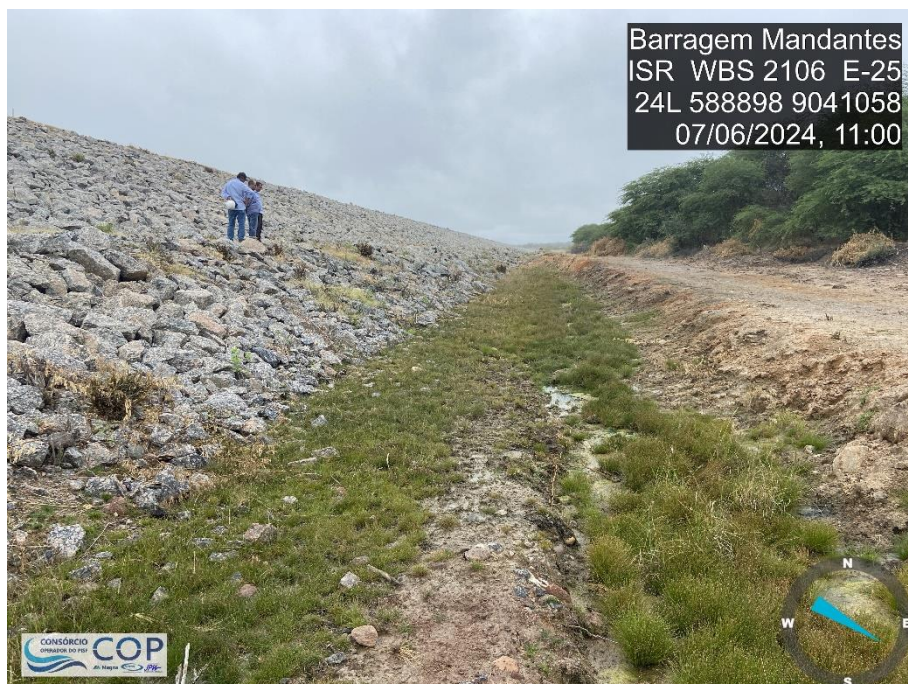
Foto 6.10: Surgências de água na região a jusante – Entre as estacas E 24+00 e E-28+00.
