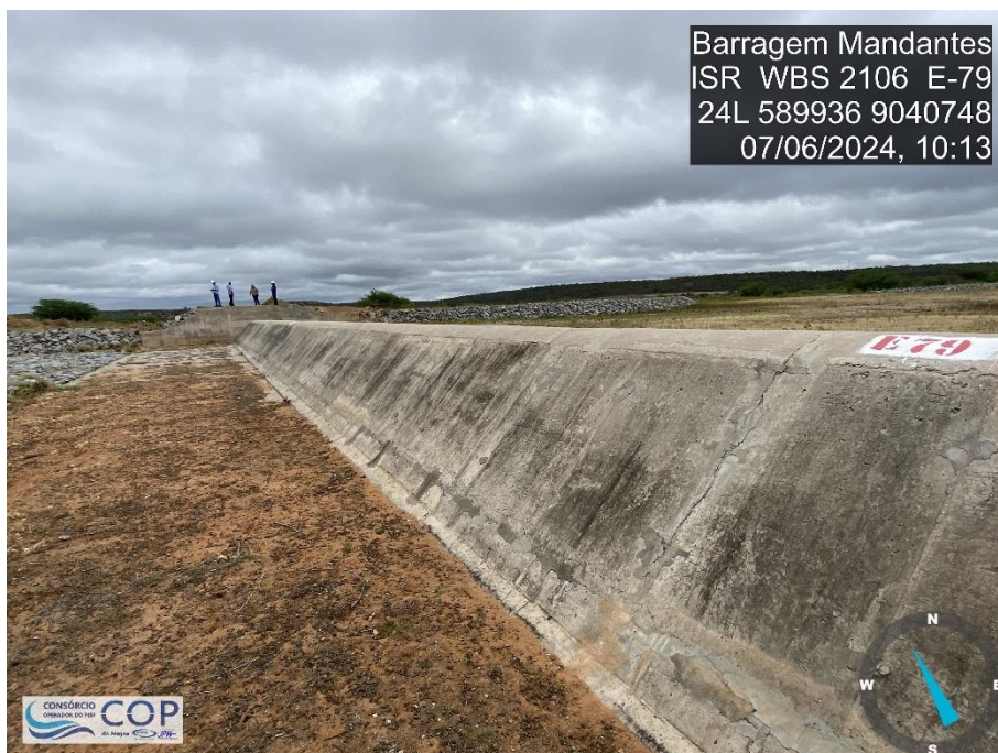
Foto 6.20: Vista da estrutura de fixação da soleira do vertedouro.
