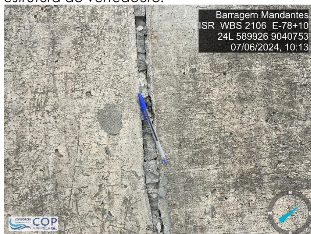
Foto 6.24: detalhe do mal acabamento do concreto da estrutura do vertedouro.
