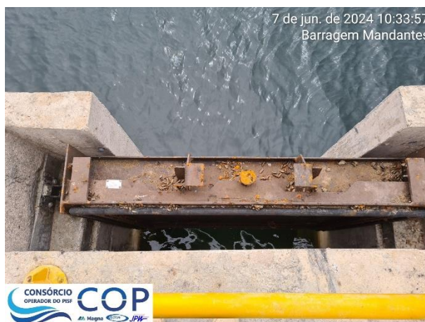
Foto 6.35: Sinais de oxidação na comporta ensecadeira e nas guias de descida da comporta/grade.
