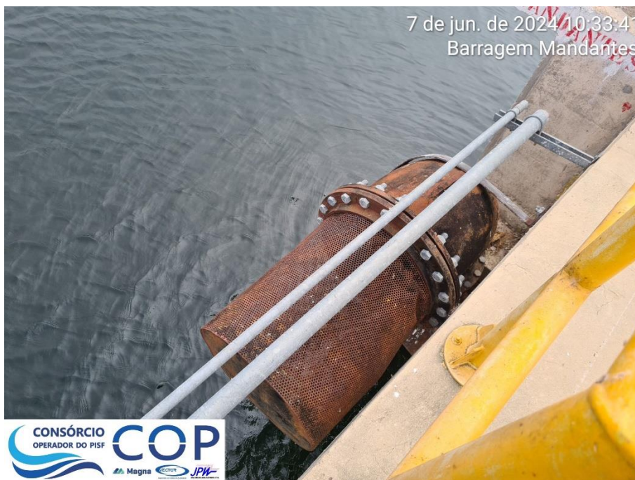
Foto 6.37: Sinais de oxidação na tubulação de aeração.
