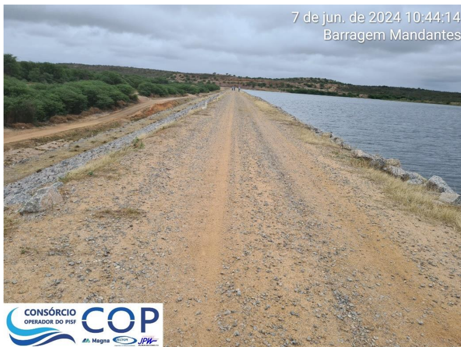
Foto 6.4: Vista do coroamento da barragem, apresentando sinais de tráfego de veículos.
