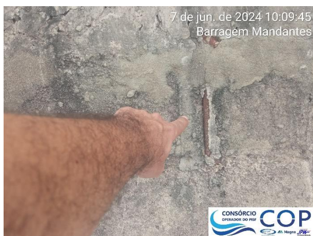
Foto 6.21: Detalhe da ferragem exposta na estrutura do vertedouro.
