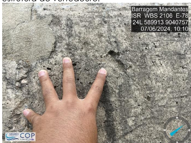
Foto 6.23: detalhe do mal acabamento do concreto da estrutura do vertedouro.
